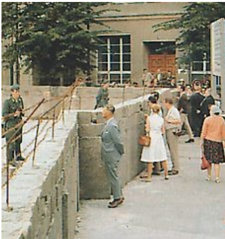
Document 6 : Construction du mur
